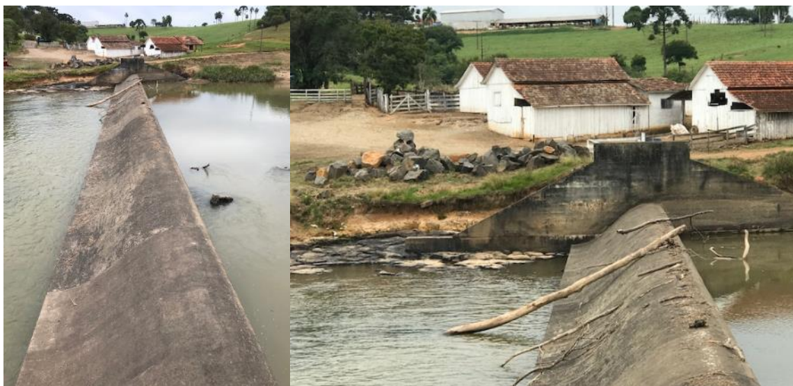
Figura 4. Barragem existente - ogiva Creager
