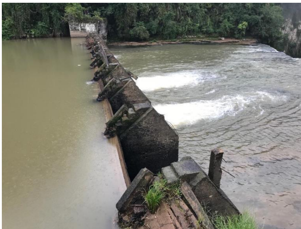
Figura 13. Barragem Vertedouro da CGH Salto Rio Branco.
