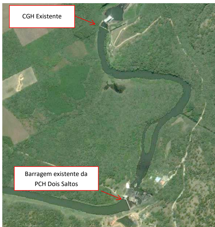
Figura 12. CGH Salto Rio Branco a jusante
