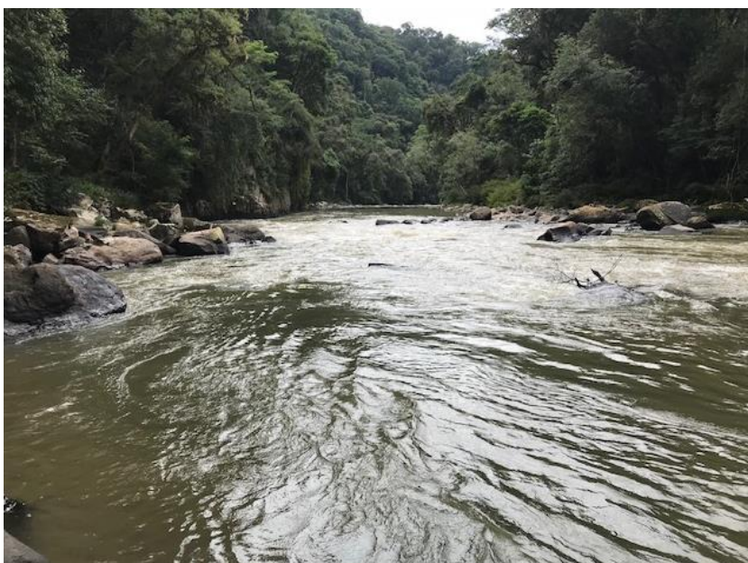
Figura 1. Vale a jusante da futura casa de Força da PCH Dois Saltos
